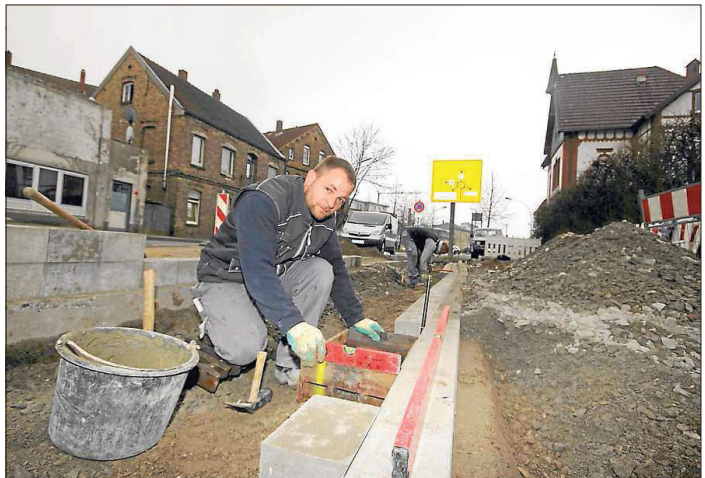
Alle Hände voll zu tun hat zurzeit Polier Dennis Falkenthal von der Firma Brockmann an der Wilhelmstraße in Rheda. Er setzt gerade die Rinne zur Entwässerung. Mit seinen Kollegen ist er, vom Bahnhof aus in Richtung St.-Clemens-Kirche betrachtet, auf der linken Straßenseite im Einsatz. Bilder: Werneke
